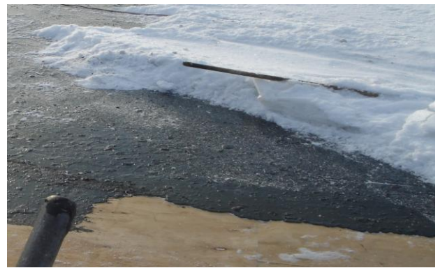
Обустройство сливных воронок материалом ВИР-ПЛАСТ и установка дефлекторов
