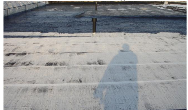
Устройство армирующего слоя из стеклоткани при выполнении работ по ВИКМ технологии (применяется в основном на зданиях из металлокаркаса или по желанию Заказчика)
