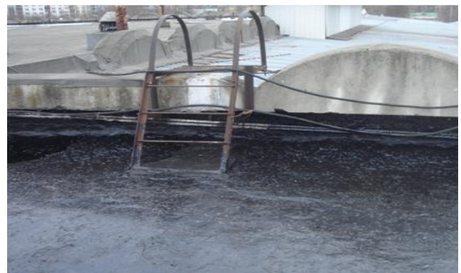
Устройство армирующего слоя из стеклоткани при выполнении работ по ВИКМ технологии (применяется в основном на зданиях из металлокаркаса или по желанию Заказчика)
