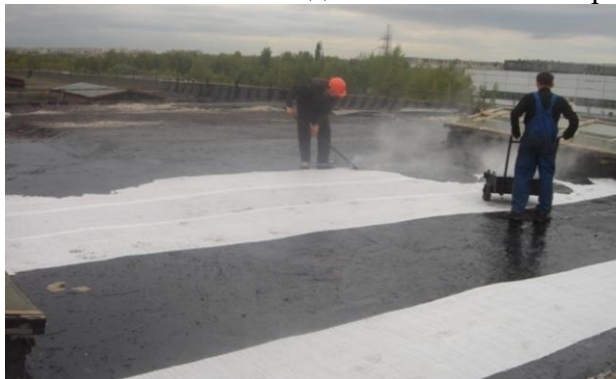
Устройство армирующего слоя из стеклоткани при выполнении работ по ВИКМ технологии (применяется в основном на зданиях из металлокаркаса или по желанию Заказчика)
